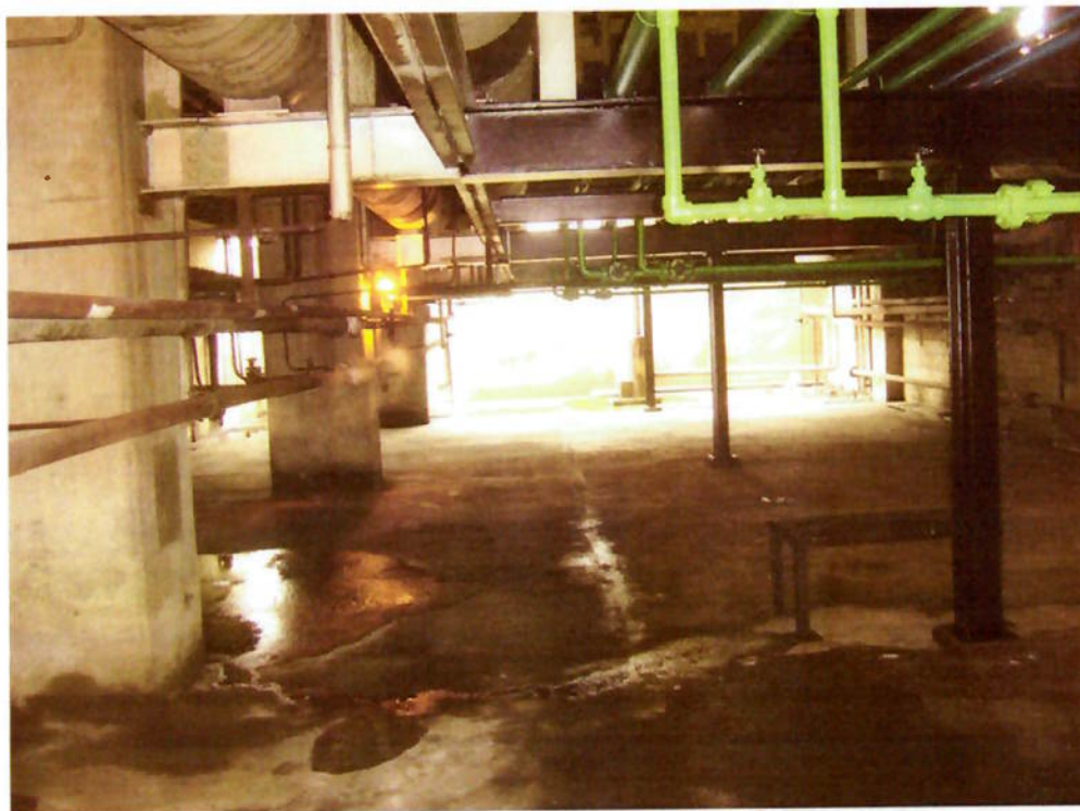
Fig. 16 – Local das medições no subsolo.
